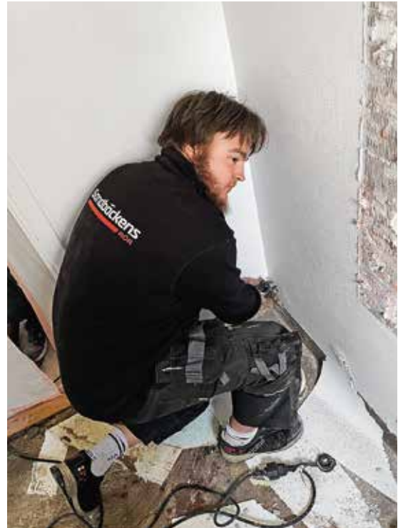
Joakim, rörmokare på Sandbäckens, demonterar rör under en badrumsrenovering.
