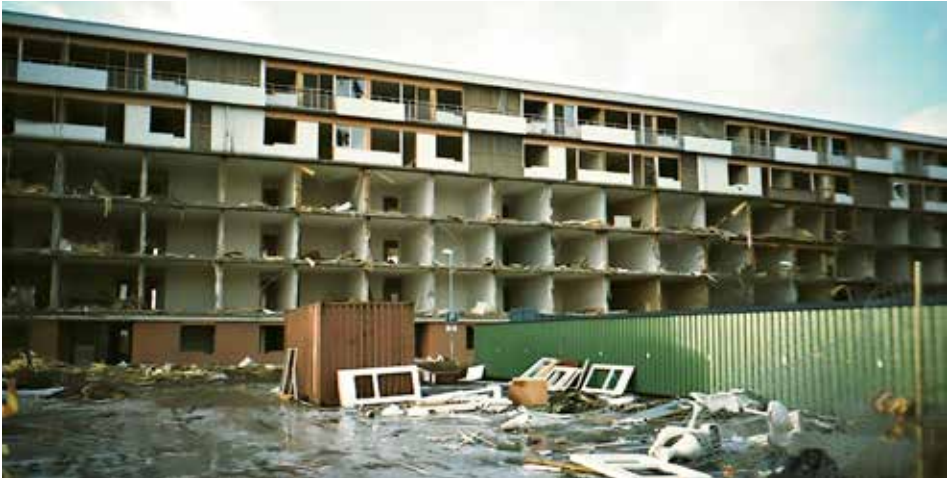
Rivning i Östra Nibble.
