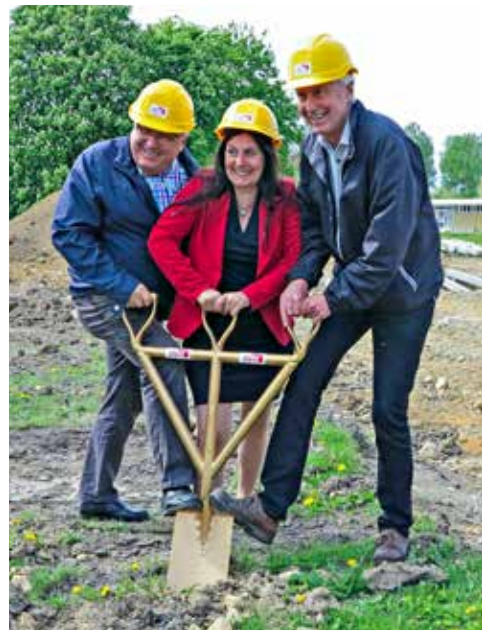
Första spadtaget tas på fastigheten Eldsboda. På bilden ser vi Hallstahems styrelseordförande Rolf Hahre, kommunstyrelseordförande Catarina Pettersson och Hallstahems dåvarande vd Per-Arne Gunnarsson.
