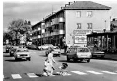
Parkgatan före ombyggnaden.
