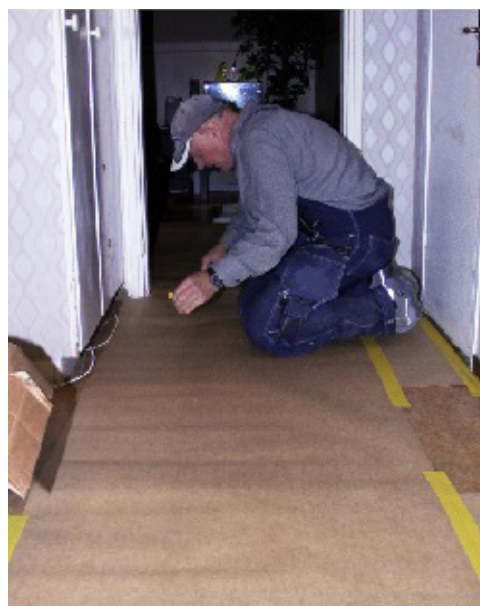
Entreprenören täcker golven för att skydda mot skador och smuts.
